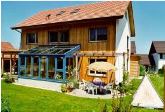
Gut: unauffällige Photovoltaikanlage auf Wintergarten
