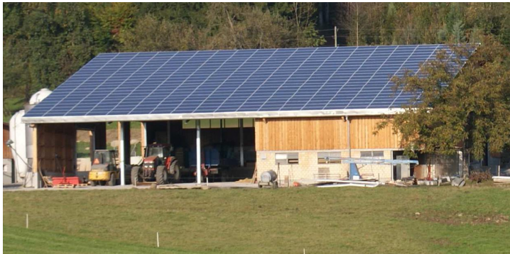
Schlecht: auffällige Farbe von Kollektoren und Kollektorrahmen
