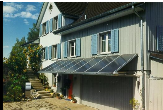
Schlecht: auffällige Solaranlage auf unnötig wirkendem Vordach.
