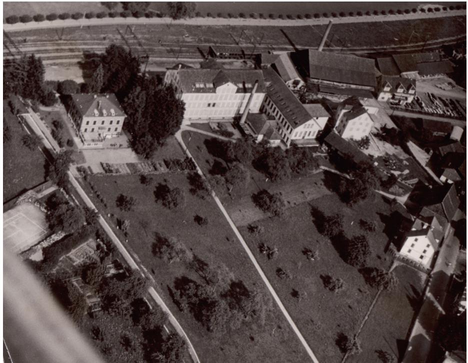
Abb. 1: Flugaufnahme des Areals der Seidenzwirnererei Zinggeler AG von Südwesten (historische Aufnahme, nicht datiert)
